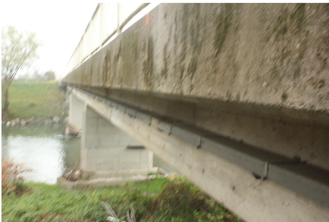
Pogled na instalacijsko kineto na gorvodni strani
