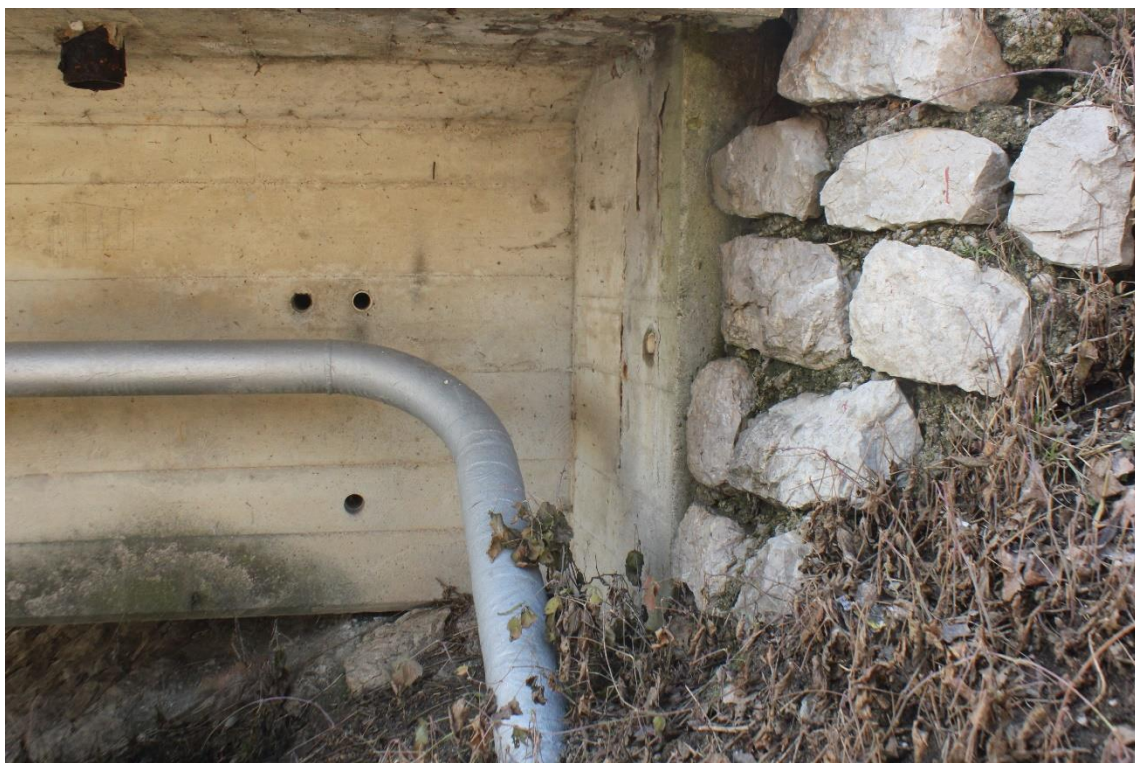
Pogled na prehod plinovoda na levi obali dolvodno v teren in prikaz meteorne odvodnje
