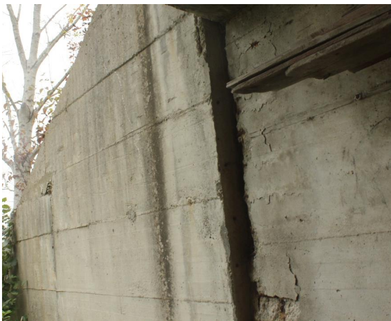
Na sliki vidna deformacija levo obrežnega gorvodnega krila, tekom sanacije se bo z odkopom ugotovil razlog
