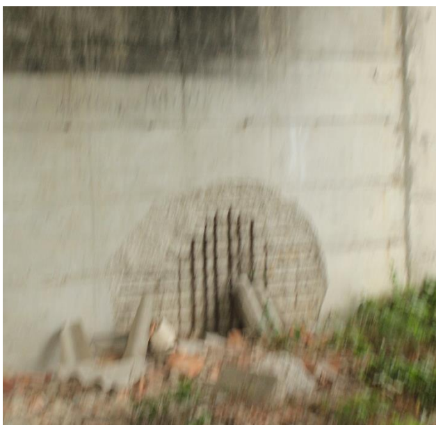
Primer odluččenja zaščitnega sloja betona na innundaciji (do odriva je prišlo zaradi rjavenja-pojav karbonatizacije)
