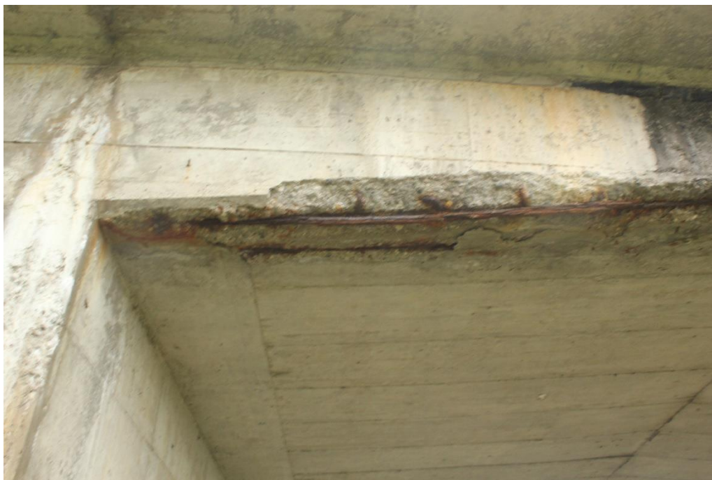
Vidno odluščenje betona na robu plošče innundacije dolvodno
