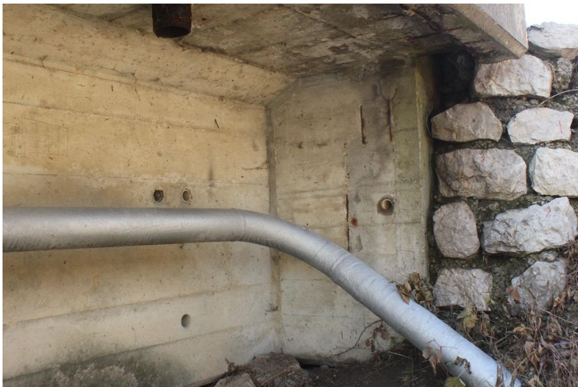
Pogled na prehod plinovoda na levi obali dolvodno v teren in prikaz meteorne odvodnje
